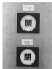
エレベーターの「開」のボタンに『あけ』、「閉」のボタンに『しめ』の点字が表記されています。
